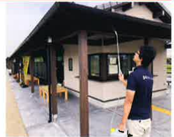
施工時間は、戸建住宅で30分程度です。
